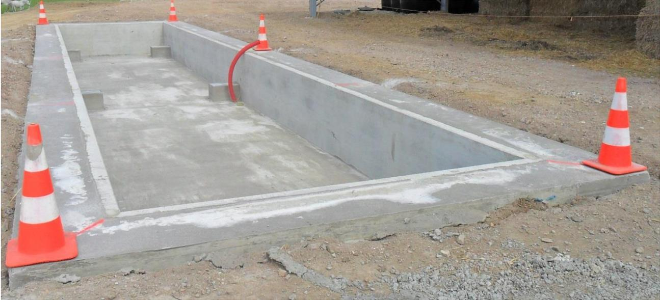
Réalisation de 6 Massifs de pose coulés de niveau au fond du terrassement pour les murs préfabriqués.
